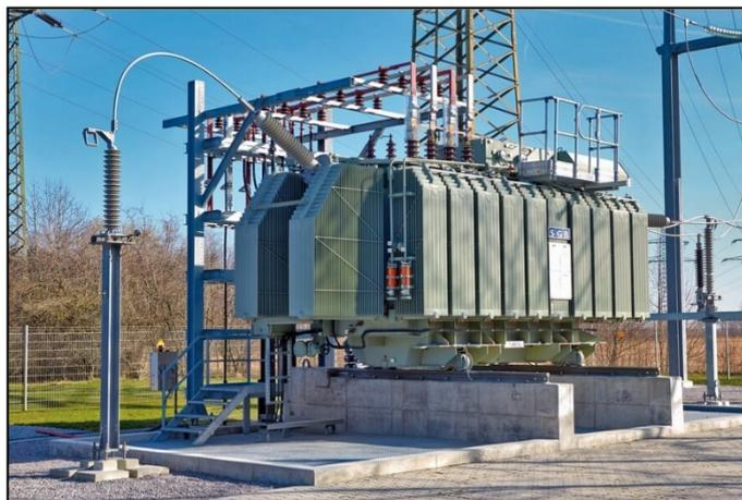
*Esempio di vasca di raccolta olio isolante Trasformatore. (Fonte: web)*
