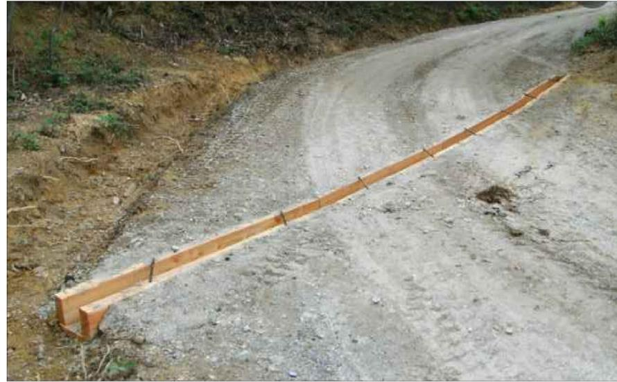
Pianta tipico canaletta in legno - viabilità di progetto con pendenza superiore al 10% - Scala 1:50
