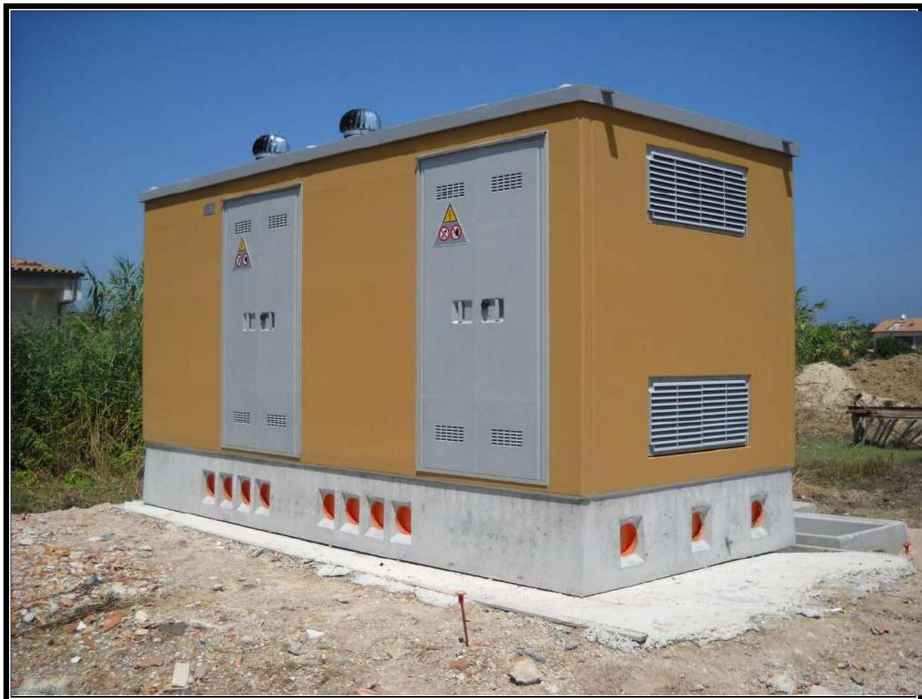
Figura 10 - ESEMPIO DI CABINA DI PARALLELO MT
