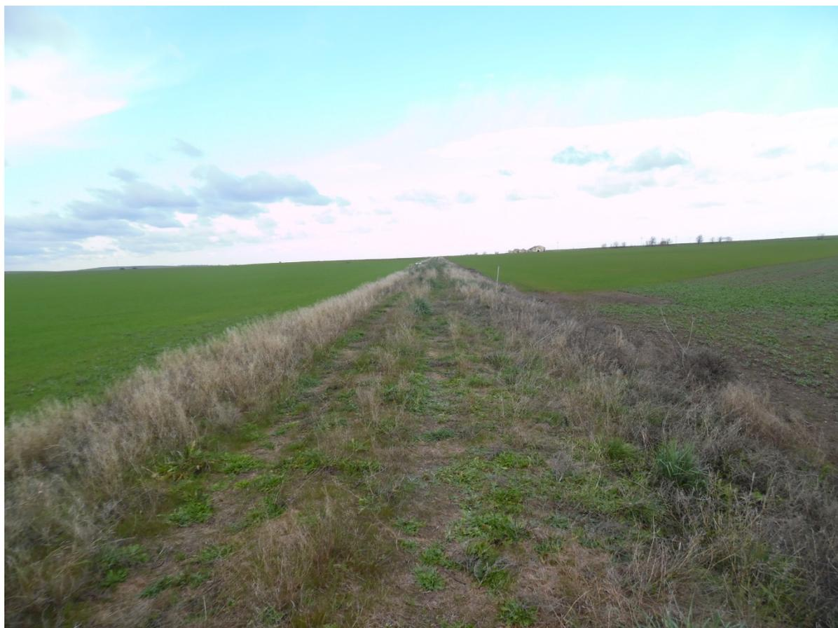
**Figura 5: Vista acquedotto interrato, in tale punto il terreno risulta leggermente sopraelevato.**
