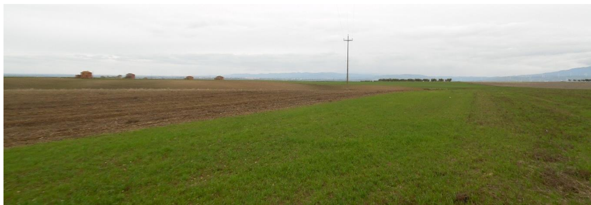
Figura 10 Linea di MT a sud est dell'impianto
