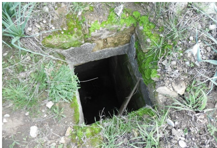
Figura 13 pozzetto in prossimità dell'acquedotto
