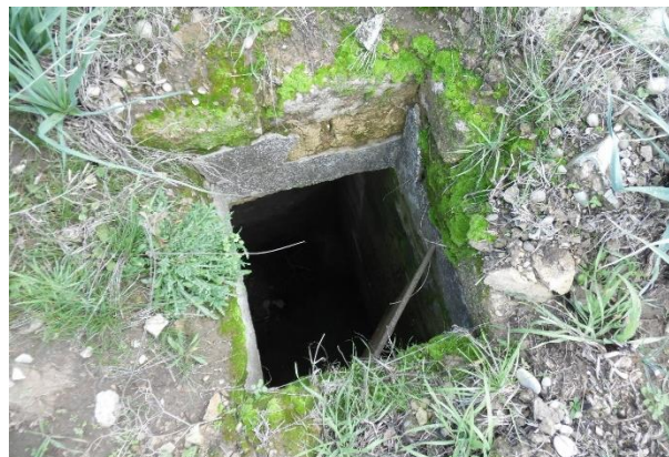
Figura 8 pozzetto in prossimità dell'acquedotto
