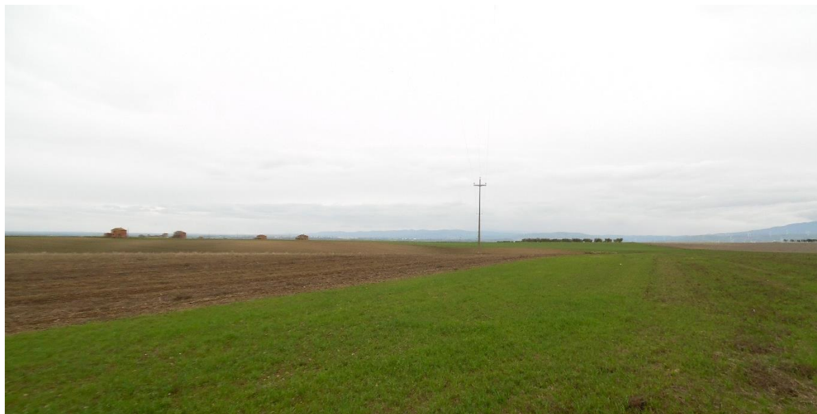
Figura 7: Linea di MT a sud est dell'impianto
