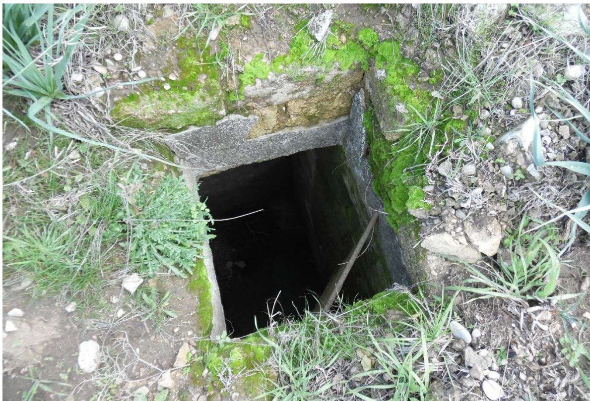
Figura 10: pozzetto in prossimità dell'acquedotto
