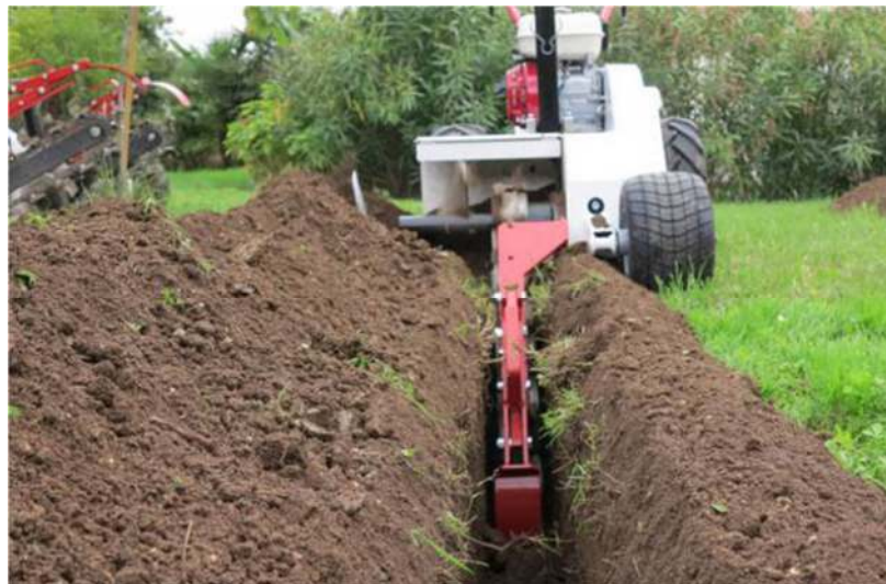
Figura 28: Particolare operazioni di scavo a sezione ristretta.
