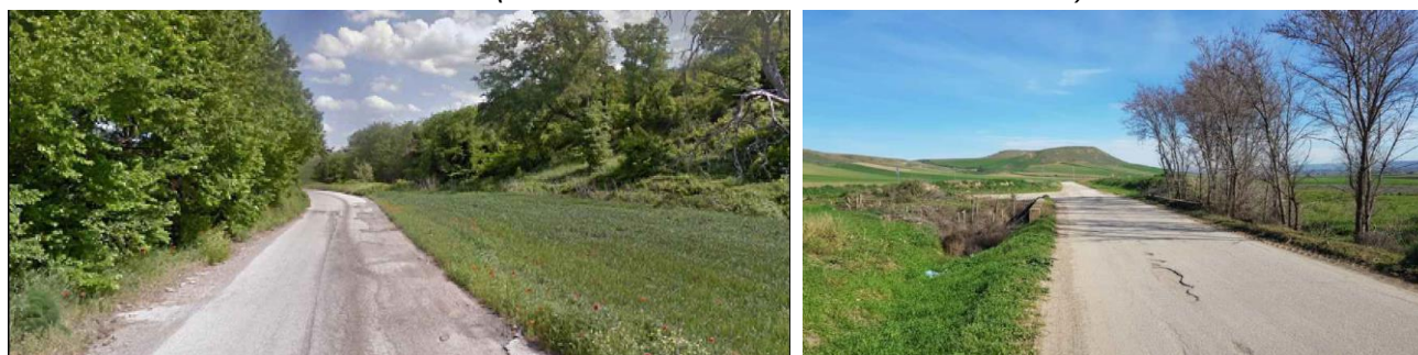
Figura 8 Stato dei luoghi area di intervento 3 (fonte: Relazione sulla risoluzione delle interferenze) e Stato dei luoghi area di intervento 4 (fonte: Relazione sulla risoluzione delle interferenze)
