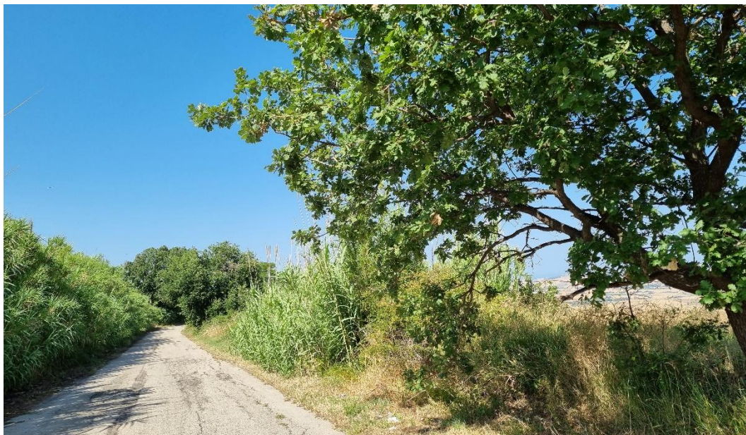
Figura 2-15: i lavori proseguono lungo la SP37 Montecifone – Le Guardate. La vegetazione principale è rappresentata da essenze di Roverella alle quali si affiancano erbe, arbusti e canneti di Arundo donax L.
