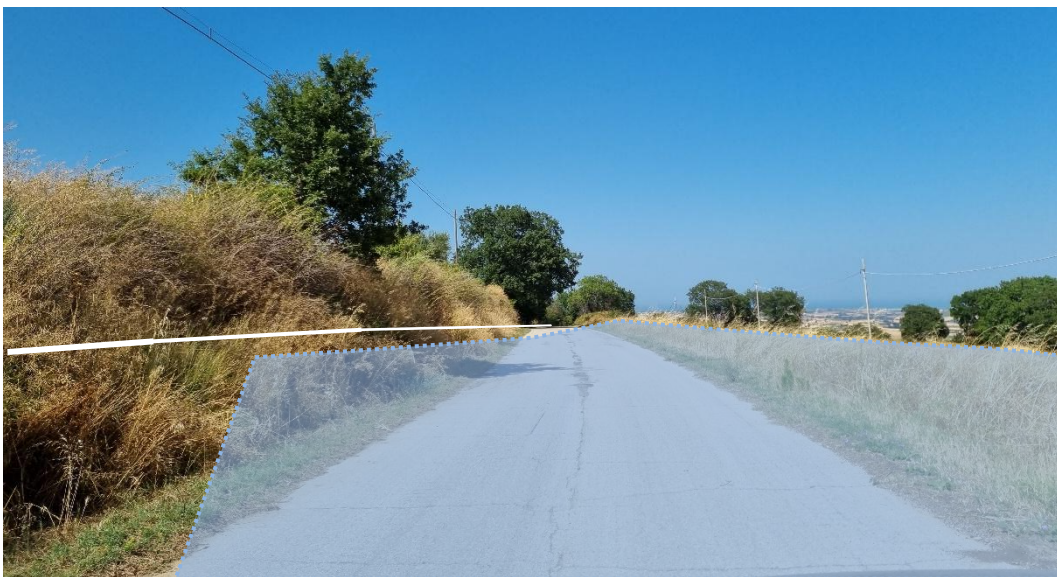
Figura 2-14: nell'immagine, la zona PF1 del PAI si trova sulla parte destra e si interrompe poco a sinistra del tracciato stradale; qui, la linea MT in progetto lascia la viabilità, si addentra nel terreno a sinistra in foto non interferendo con la zona PF1. In ogni
