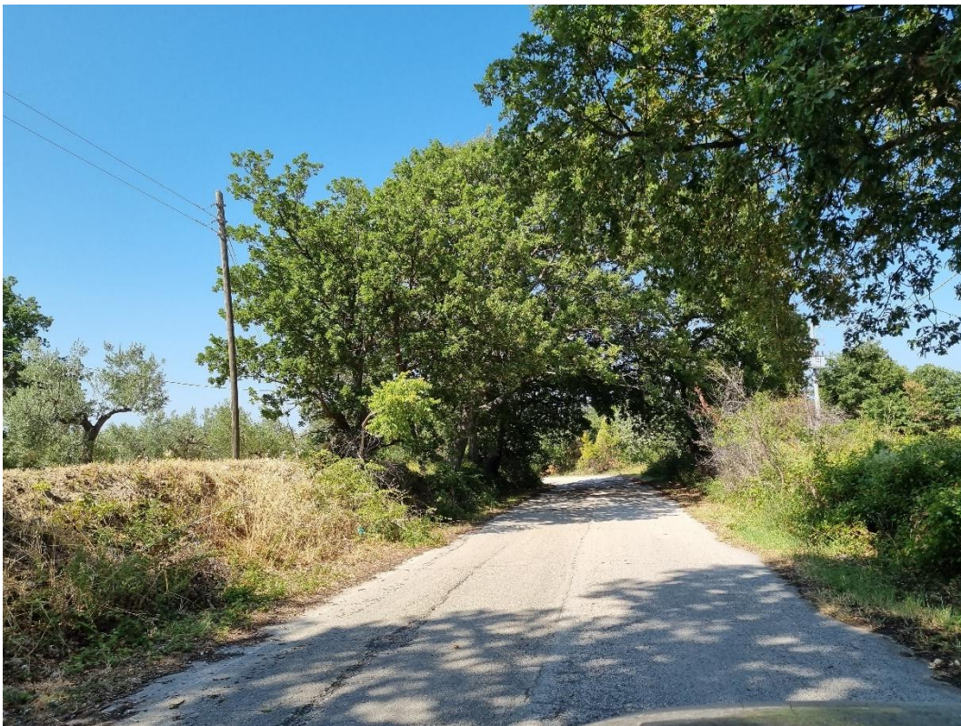
Figura 2-12: il progetto è tornato sulla viabilità principale; in questo e pochi altri punti, la presenza di rami bassi potrebbe implicare una leggera potatura. In ogni caso, si tratta di operazioni che rientrano nella normale tipologia di interventi di
