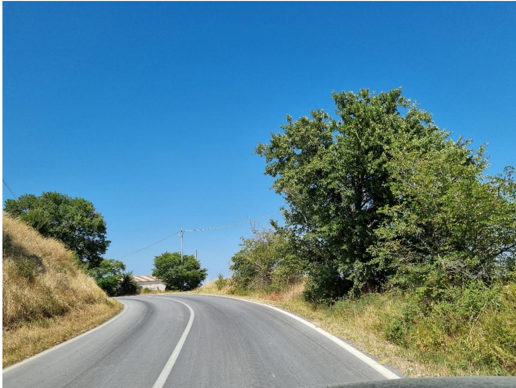
Figura 2-18: ancora la strada asfaltata principale al di sotto della quale correrà la linea MT.
