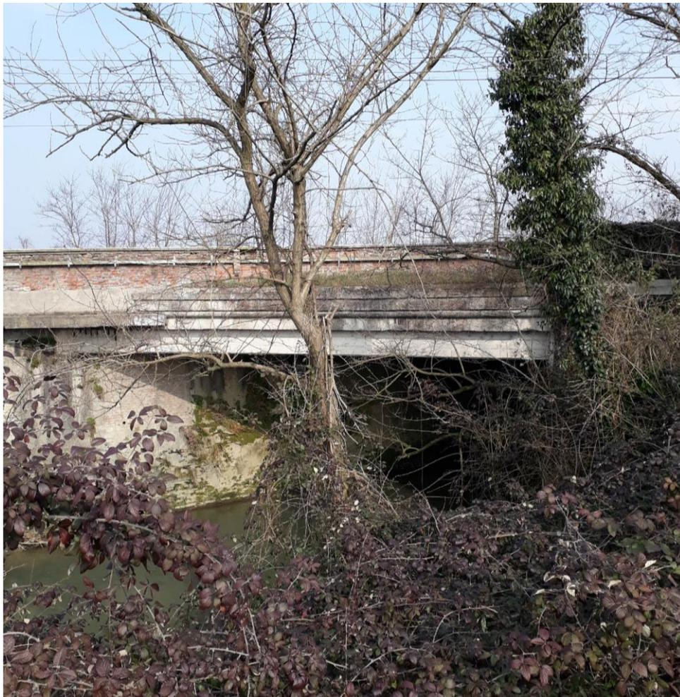
Figura 12 Ponte sul Canale Dugale: Stato attuale. Da notare la posizione delle spalle poste a diretto contatto con l'alveo
