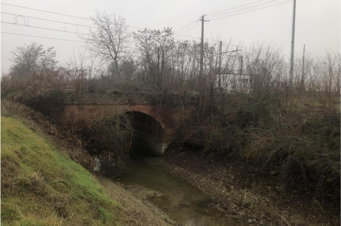
*Figura 6 Ponte sul Cavo Osone: Punto di vista A - Vista in direzione Mantova. Da notare la modesta ampiezza dell'attuale ponte, la profondità dell'incisione rispetto alla quota della linea ferroviaria, nonché la presenza di una fitta vegetazione circostante che, anche nella stagione invernale, ne impedisce la vista*
