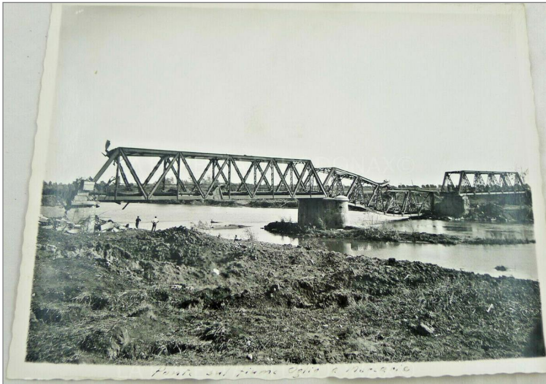
Figura 4 – Ponte originario sul Fiume Oglio: foto storica relativa ai danni causati dai bombardamenti occorsi durante il secondo conflitto mondiale
