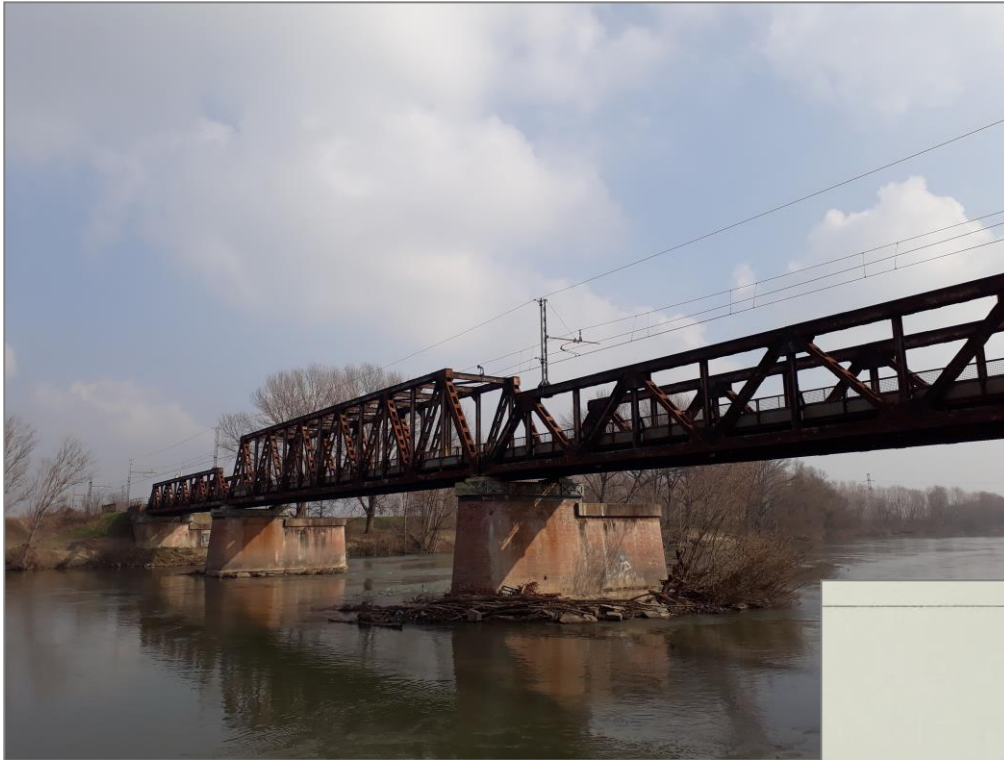
Figura 2 – Ponte esistente sul Fiume Oglio: foto configurazione attuale con vista da monte verso valle (da sopralluogo ITALFERR del 19 Febbraio 2020)
