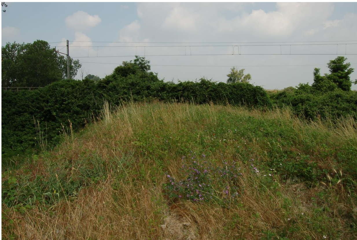
Figura 7-7: Area del rilevato spondale interposta tra le AT.11 cui risulta segnalato l'Habitat 6510
