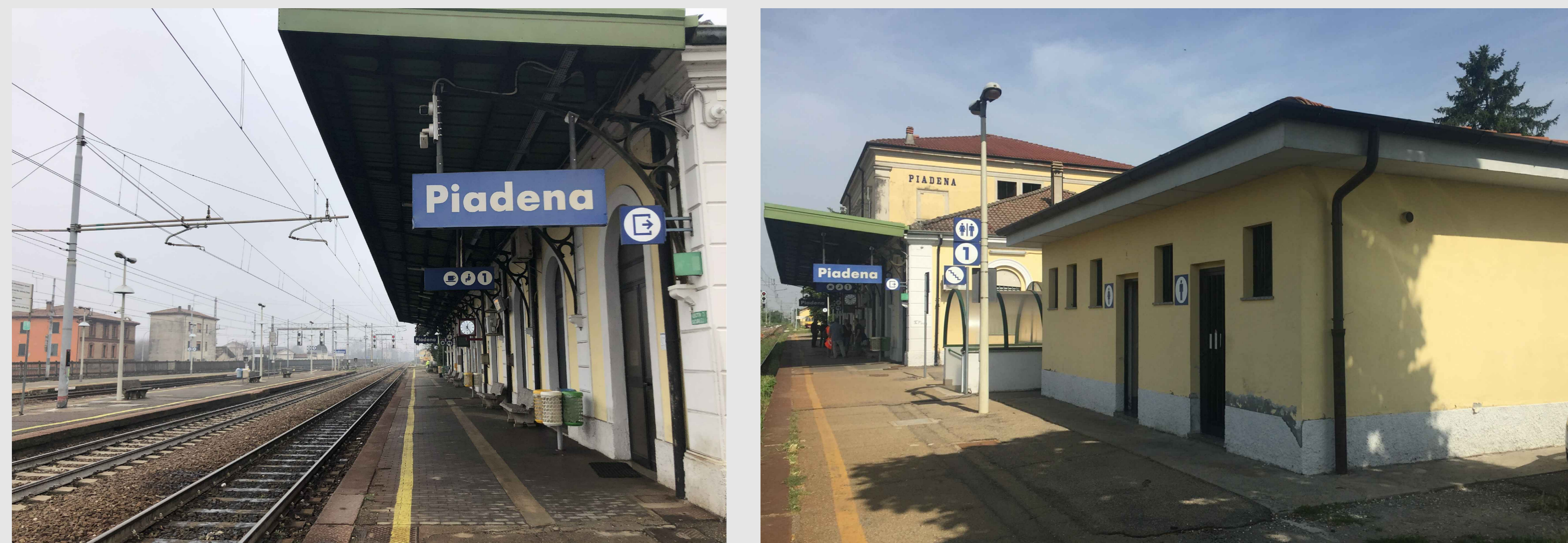
FABBRICATO VIAGGIATORI ESISTENTE FOTO LATO BINARI
