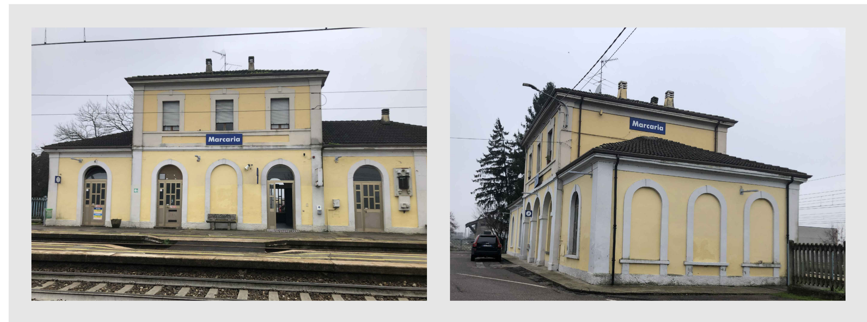
FABBRICATO VIAGGIATORI ESISTENTE FOTO LATO BINARI
