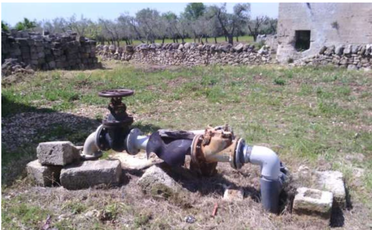
Figura 7: Porzione di condotta interrata visibile fuori terra.
