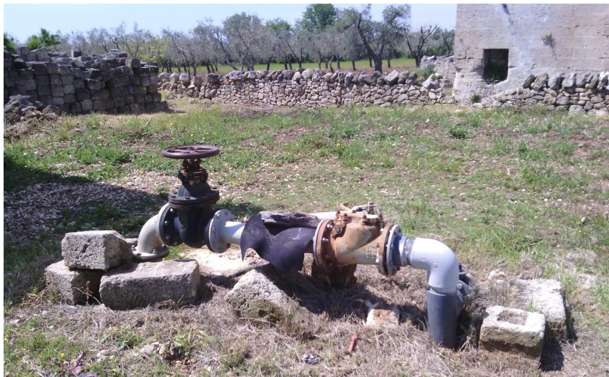
Figura 6: Porzione di condotta interrata visibile fuori terra.
