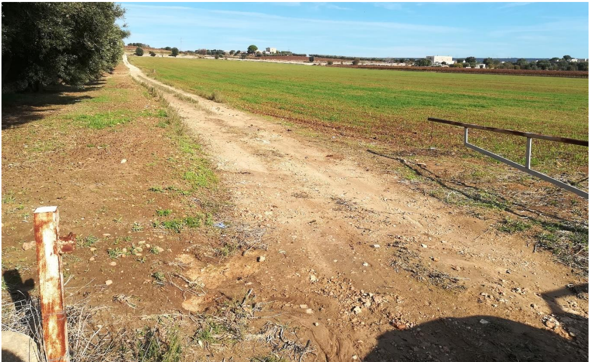
Figura 4: viabilità interna che divide l'impianto
