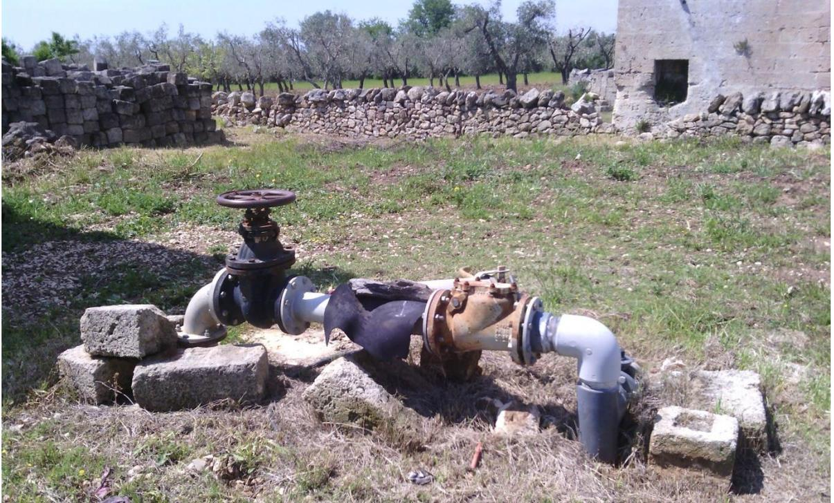
**Figura 7: Porzione di condotta interrata visibile fuori terra.**
