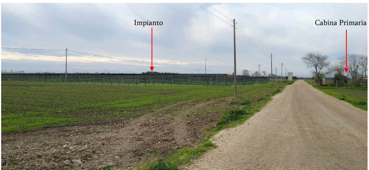
Punto di vista 3 nei pressi della Masseria Torre di Lama verso il plot 1 e la Cabina Primaria, quest'ultima schermata da elementi naturali ed antropici esistenti. Nel foto - inserimento l'impianto è rappresentato senza misure di mitigazione. Lungo questa direzione non si riscontra la presenza di ulteriori impianti esistenti e realizzandi.
