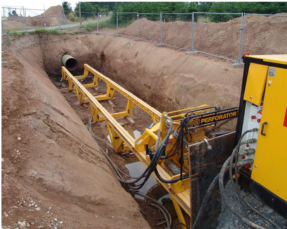
Fig. 40 - Esempio di tecnologia no dig per la posa di tubazioni
