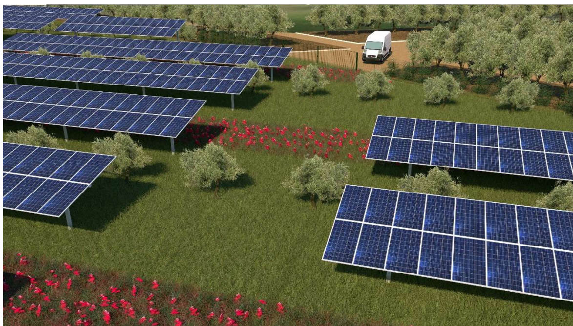
Figura 36 – Esempio vista mitigazione interna all'impianto
