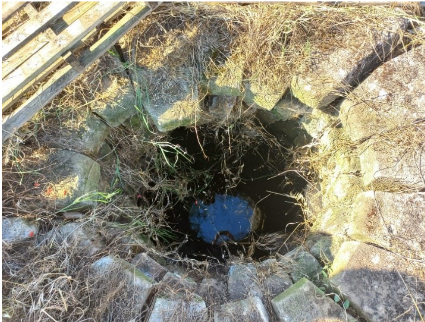
Figura 2.8: Boccapozzo del pozzo Digiesi
