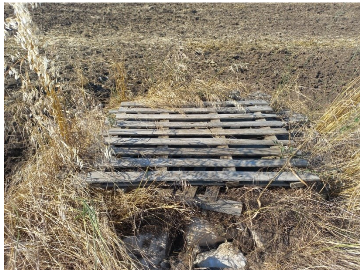
Figura 2.9: Attuale copertura del pozzo Digiesi
