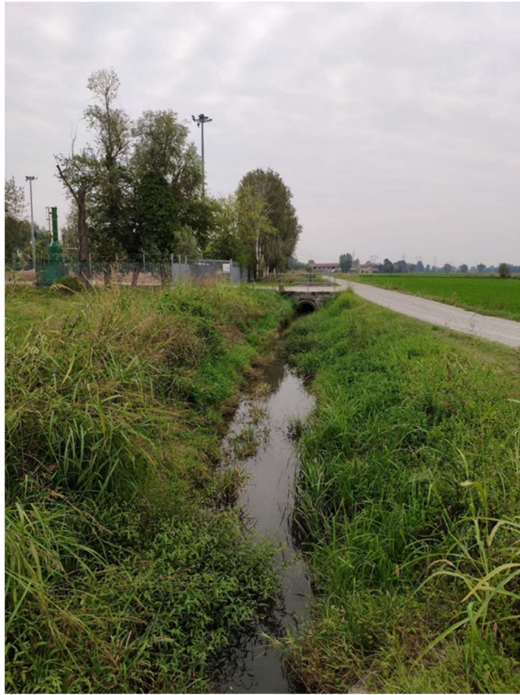
Figura 8 Roggia Fontanile Catanino (comune di Settala – area est del giacimento): esempio di mancata manutenzione del sistema idraulico, con evidenti intrusioni in alveo di tappeti erbosi consistenti a produrre occlusioni alla continuità del flusso.
