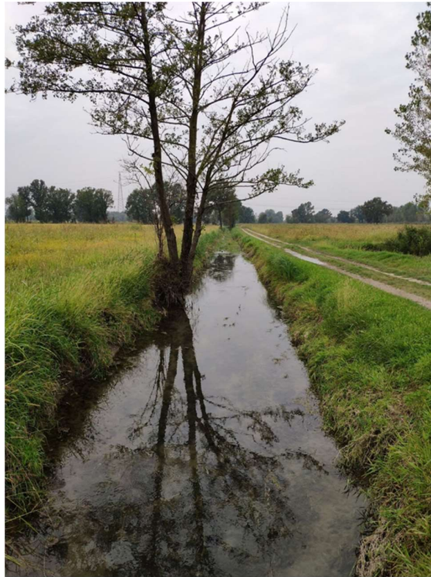
Figura 11 Cavo Fontanile Quattro Ponti (comune di Settala – area est del giacimento): tipica situazione spondale con sponde vegetate e albero in fregio alla roggia al limite del ribaltamento.
