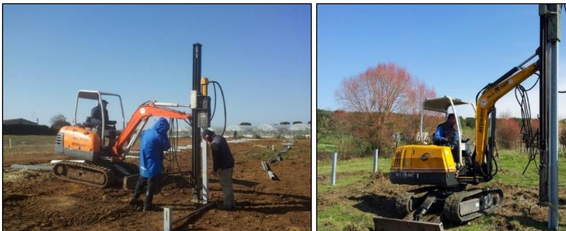
*Figura 68 - Tipologia di installazione delle strutture di sostegno dei moduli FTV con macchina battipalo*
