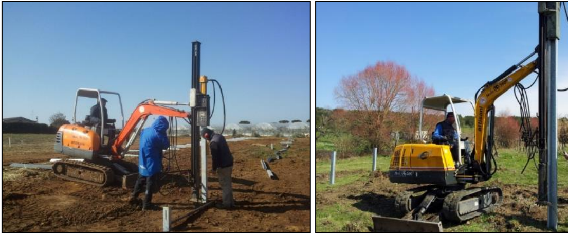
Figura 35 - Tipologia di installazione delle strutture di sostegno dei moduli FTV con macchina battipalo
