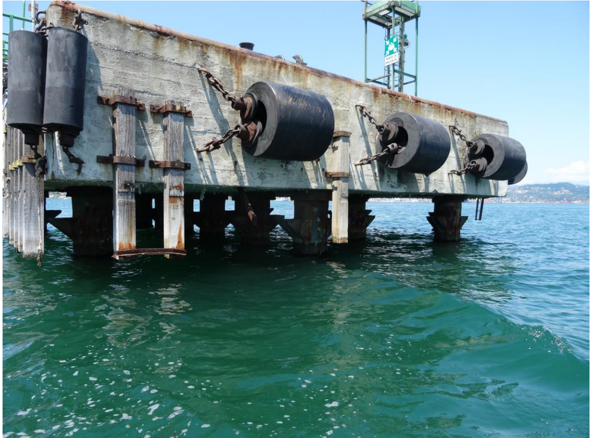
Foto 7: Briccola briccola D di ormeggio
