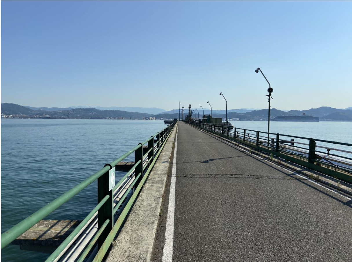
Foto 2: Vista pontile principale
