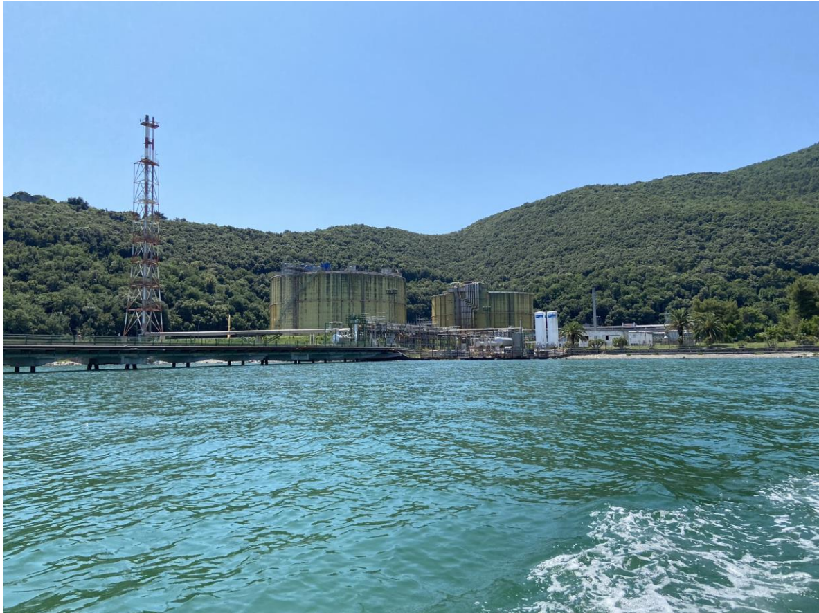
Foto 10: Vista Pipe rack
