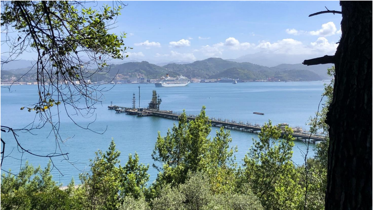
Foto 19: PV2 - Ante operam
