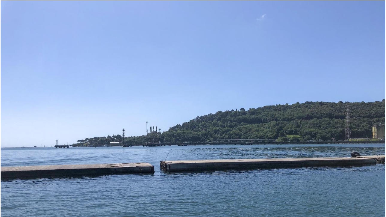
Foto 21: PV3 - Ante operam
