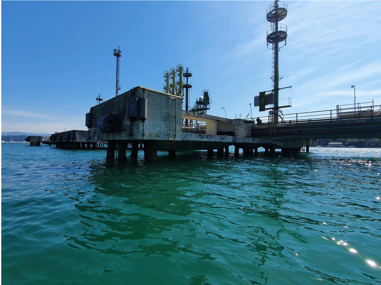
Foto 3: Vista pontile principale
