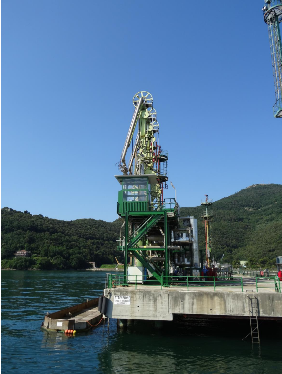
Foto 4: Bracci di carico
