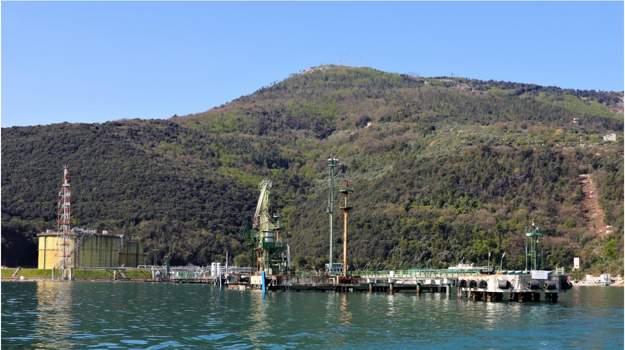
Foto 23: PV4 - Ante operam
