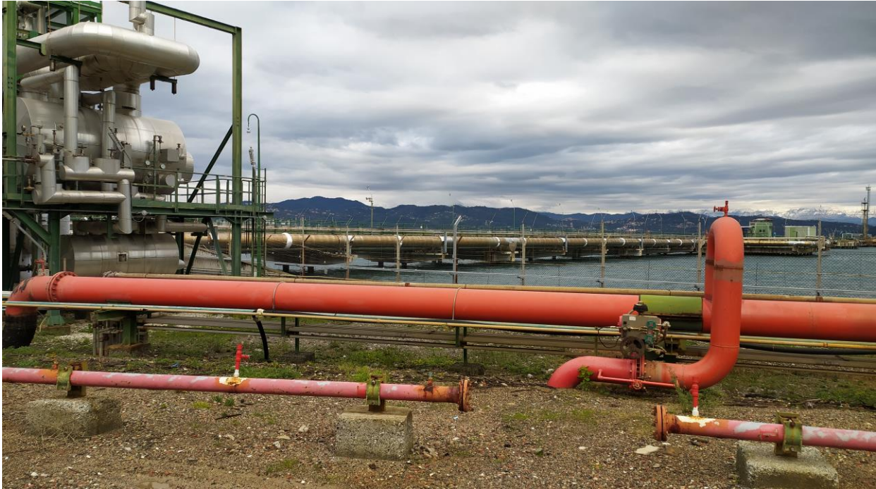
Foto 13: Vista del pontile principale da terra
