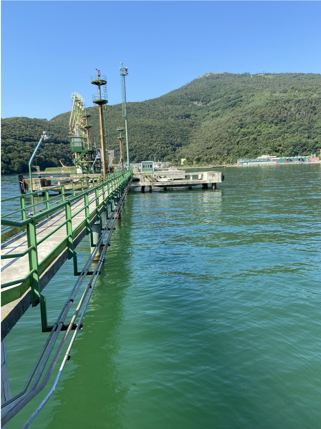
Foto 5: Vista pontile principale direzione terra
