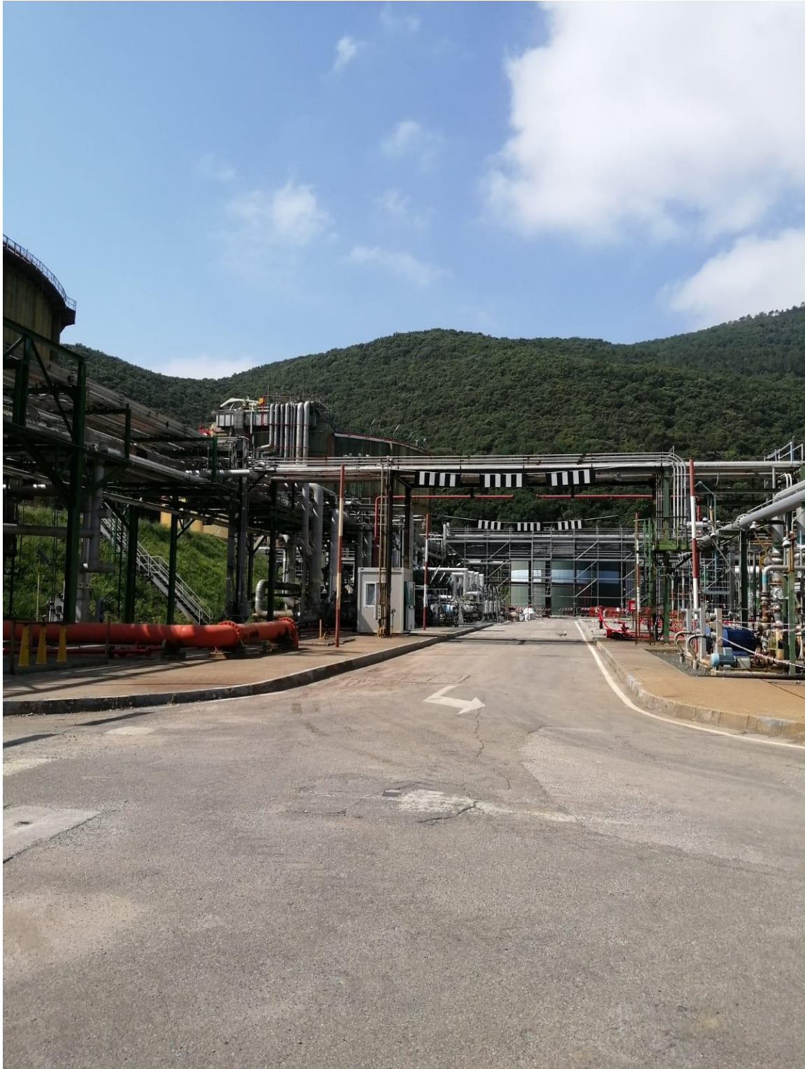
Foto 11: Vista Pipe rack da terra
