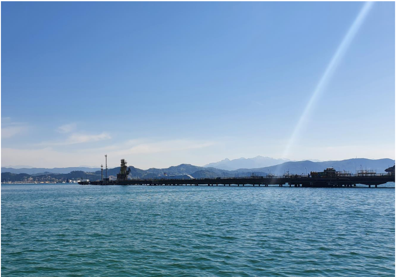
Foto 1: Vista pontile principale
