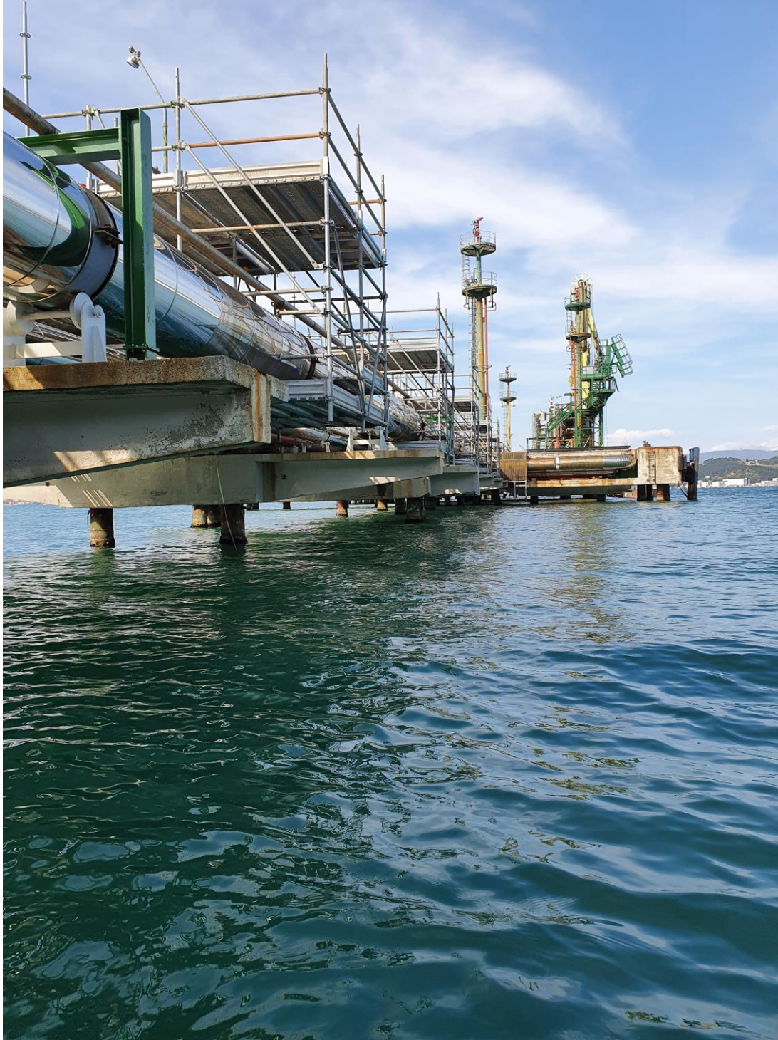
Foto 6: Dettaglio linea di trasferimento GNL
