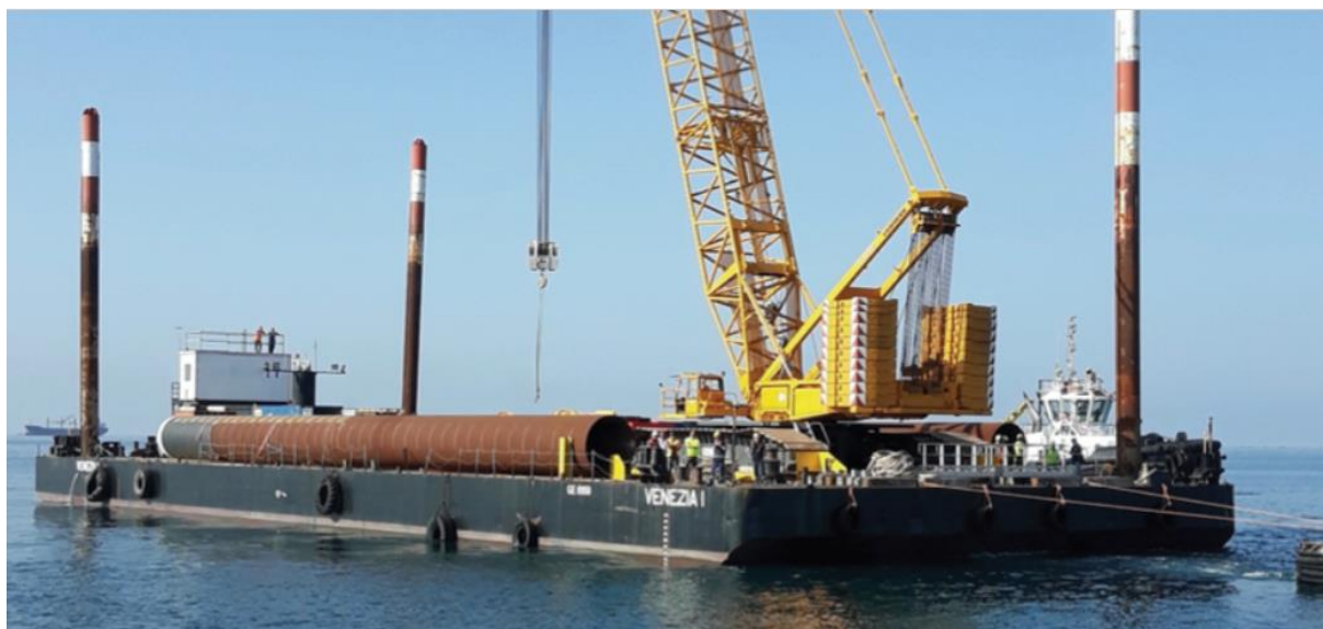
Figura 31 Pontone principale con gru per sollevamento e infissione pali
