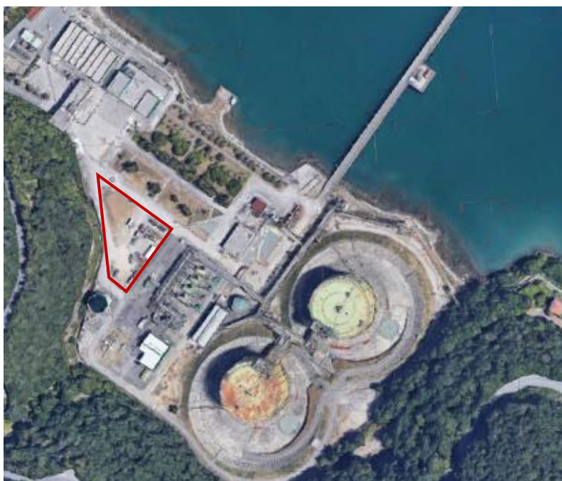
Figura 34 Area logistica di cantiere interna al Terminale
