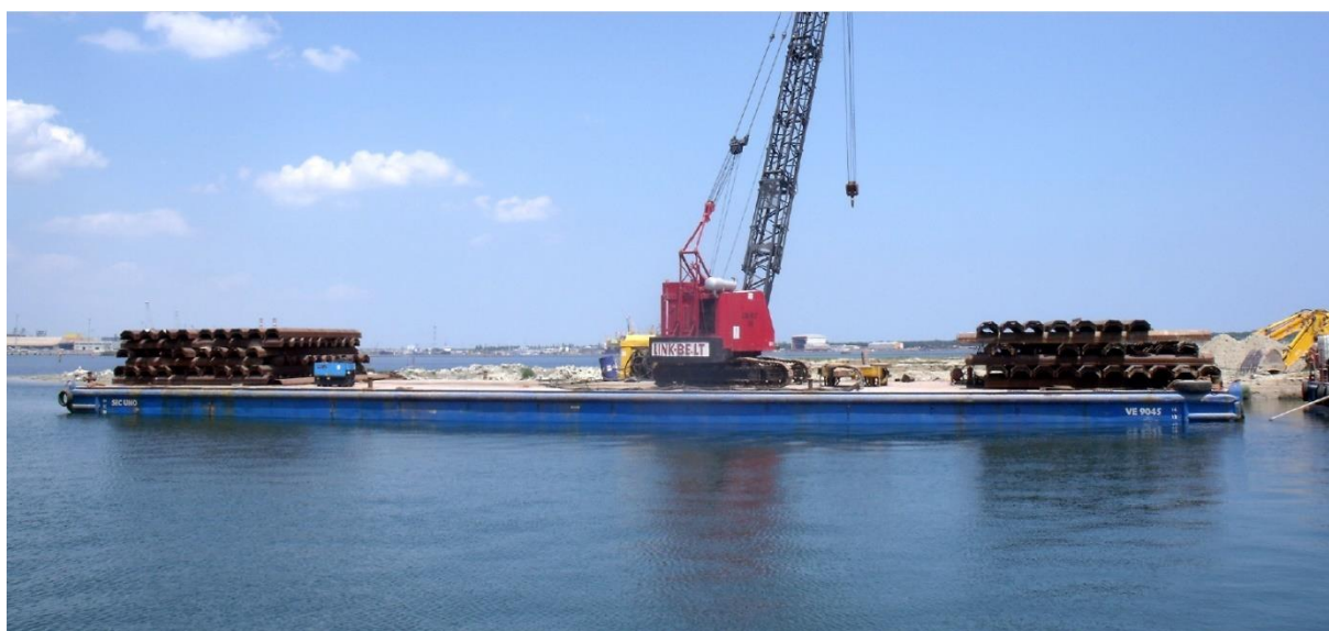
Figura 32 Pontone secondario per stoccaggio pali
