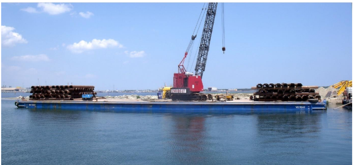
Figura 44: Pontone secondario per stoccaggio pali
