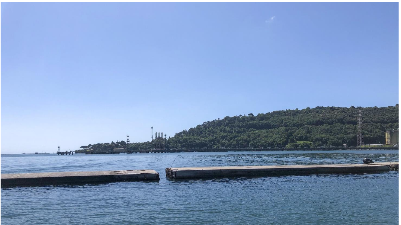
Figura 37: PV3 - Post operam
