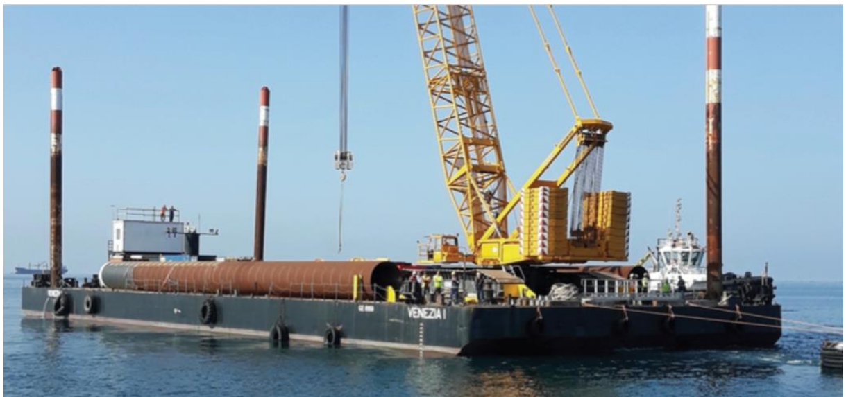
Figura 43: Pontone principale con gru per sollevamento e infissione pali
