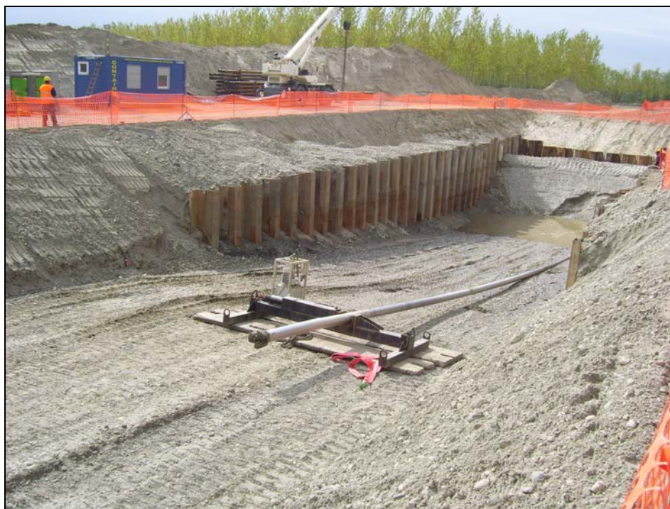
Attraversamento F. Po con met. 30" – fase di uscita dell'asta pilota
