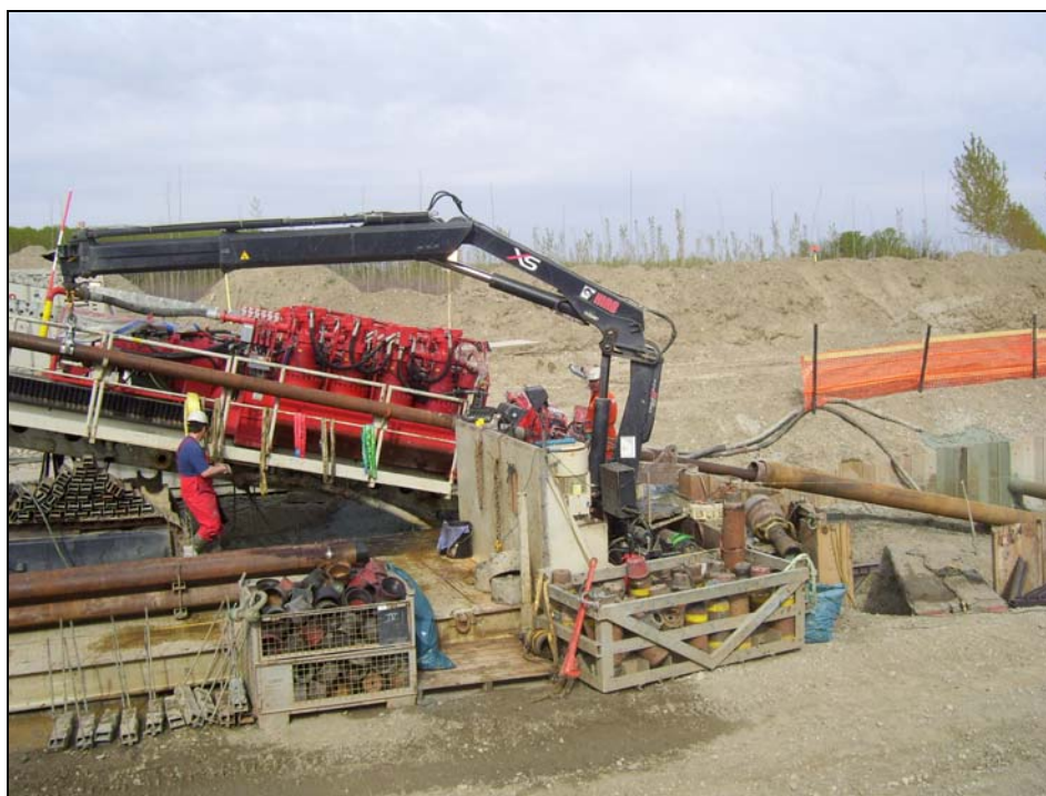
Attravers. F. Po con met. 30" – "Rig", durante la realizzazione del foro pilota
