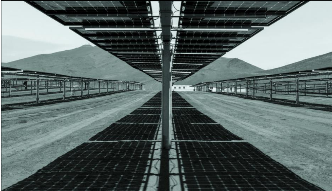
Figura 29 - Esempi di tracker per impianti fotovoltaici
