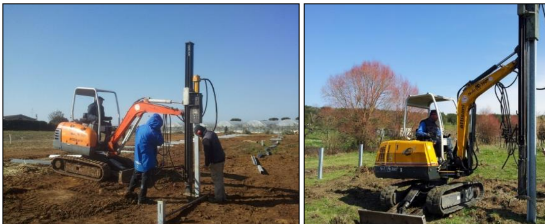
Figura 28 - Tipologia di installazione delle strutture di sostegno dei moduli FTV con macchina battipalo
