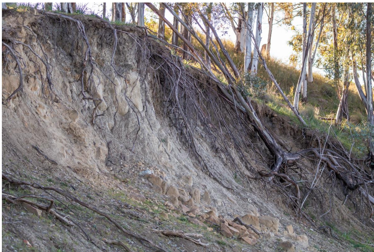
Figura 4-1. Particolare di ciglio di erosione. Appare evidente come lo strato esplorato dalle radici rimanga piuttosto superficiale. (Foto 8)
