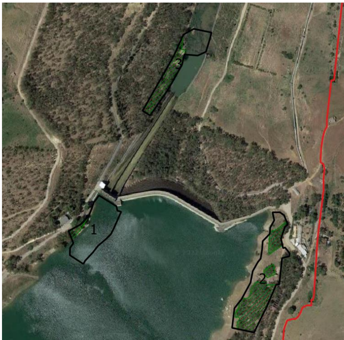
Figura 2-1. sovrapposizioni del cantiere con aree forestali
