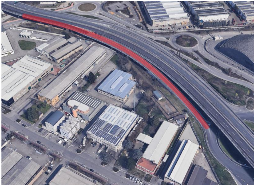
Zona di intervento rampa Nord
