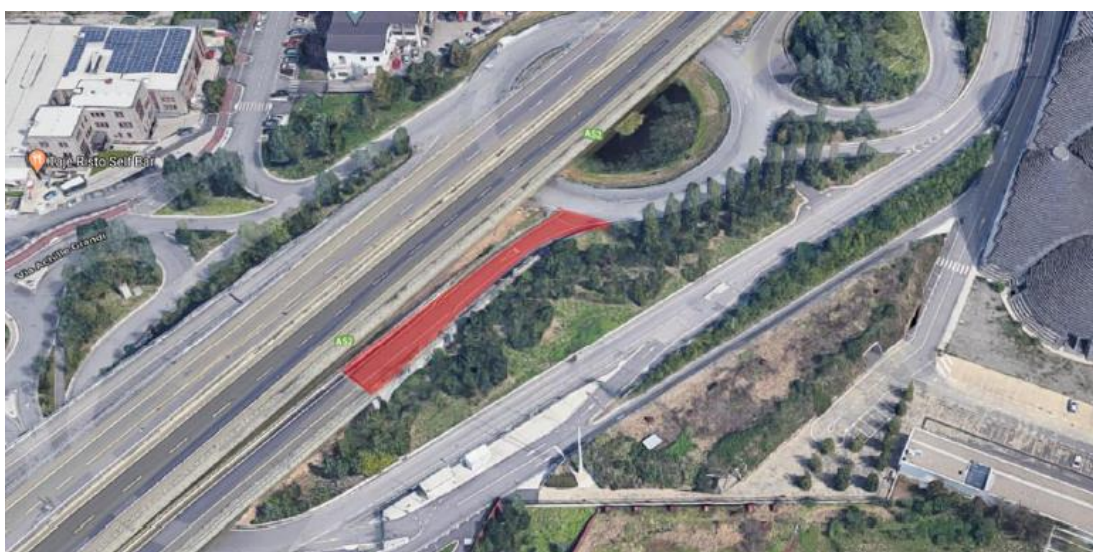
Zona di intervento rampa Sud
