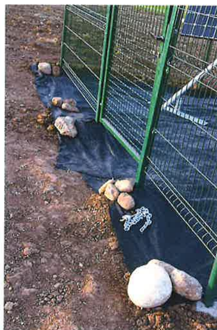
Dettaglio recinzione lato Nord
