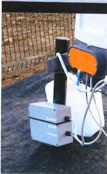
Quadro contenimento DC/DC converter
