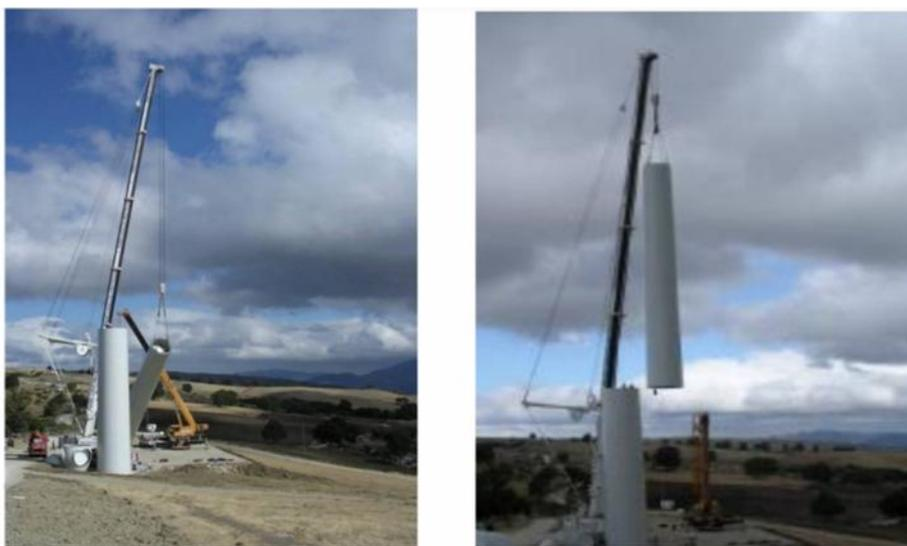
*Figura 24 – Fasi di montaggio della torre dell'aerogeneratore.*
