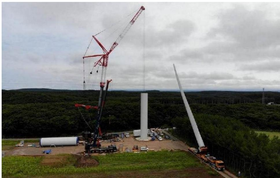
*Figura 14 – Fasi di montaggio della torre dell'aerogeneratore.*
