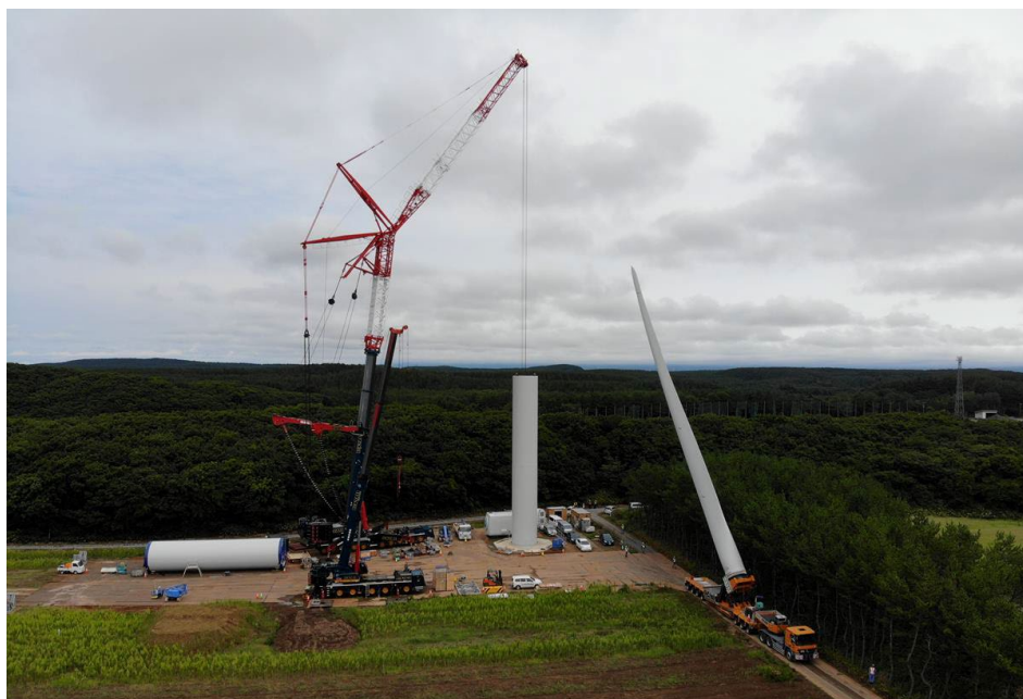
Figura 3 – Fase di montaggio dell'aerogeneratore con torre principale in azione e trasporto della pala con sistema blade lifter, per ridurre la lunghezza dei mezzi di rimorchio.
