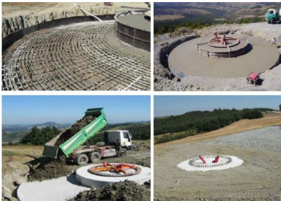
Figura 2 – Fasi di realizzazione del plinto di fondazione dell'aerogeneratore.
