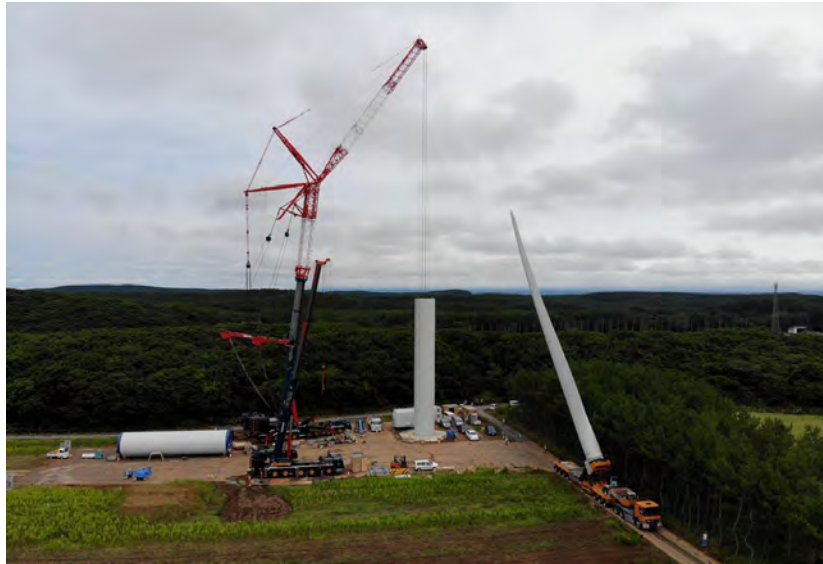
Figura 4 – Montaggio dell'aerogeneratore con gru principale.
