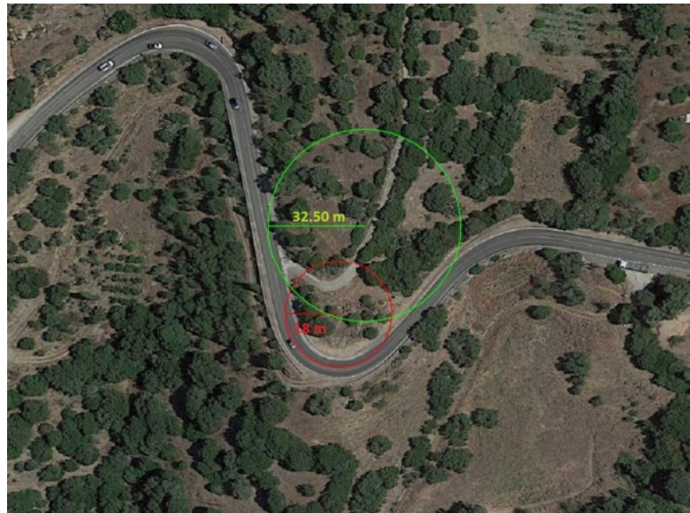
Figura 47 – Immagine del tornante soggetto a sbancamento sulla S.P.23.
