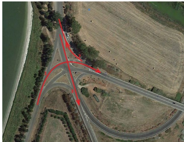
Figura 33 – Immagine delle manovre da effettuarsi per tratto di immissione dalla SP49 alla SP59, angolo a 40°
