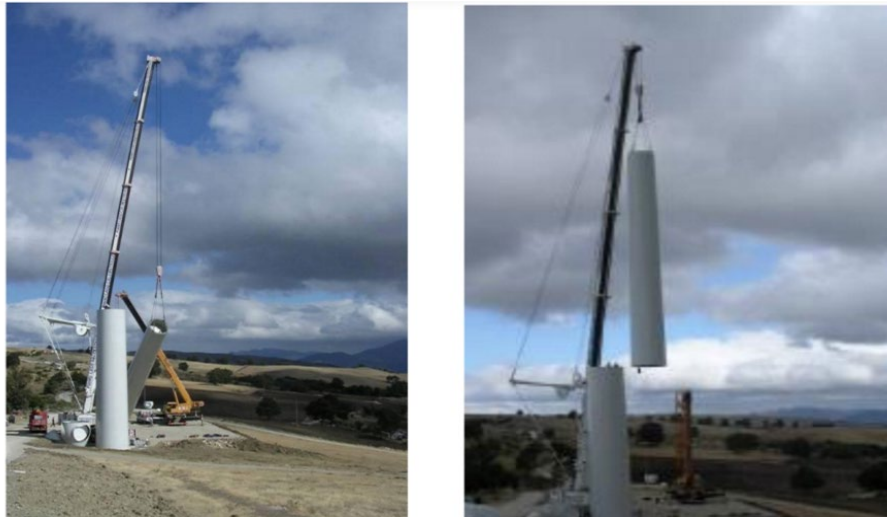
Figura 60 – Fasi di montaggio della torre dell'aerogeneratore
