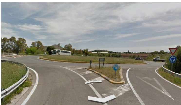
Figura 36 – Inquadramento della rotatoria sulla SS128 dal lato sud-ovest.
