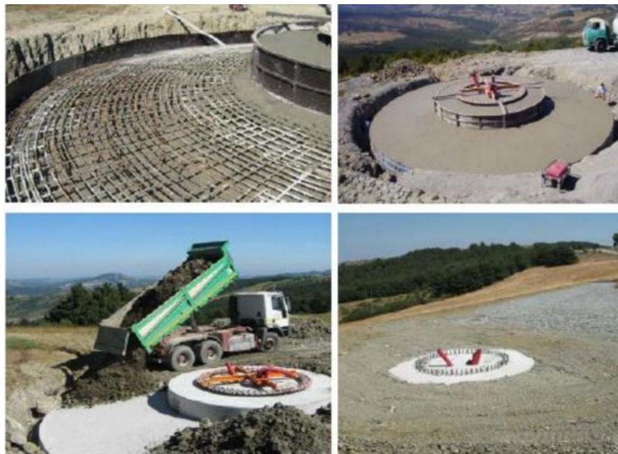
Figura 51 – Fasi di realizzazione del plinto di fondazione dell'aerogeneratore
