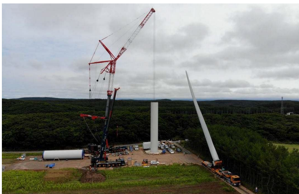
Figura 13 – Fasi di montaggio della torre dell'aerogeneratore.
