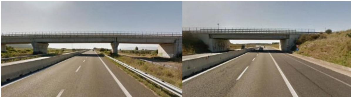
Figura 39 – Vista di alcuni dei cavalcavia esaminati.
