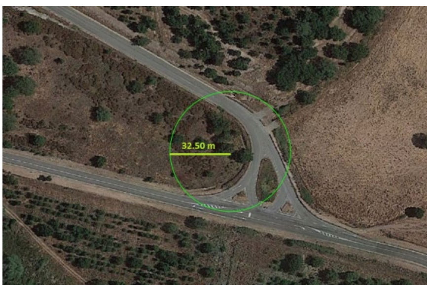
Figura 39 – Immagine dello svincolo di accesso dalla S.P.23 alla Strada Comunale di Siurgus interna al Parco.
