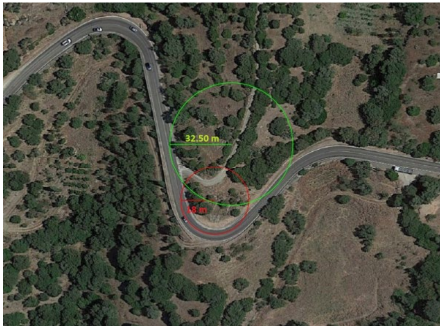
Figura 37 – Immagine del tornante soggetto a sbancamento sulla S.P.23.
