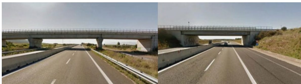
Figura 29 – Vista di alcuni dei cavalcavia esaminati.
