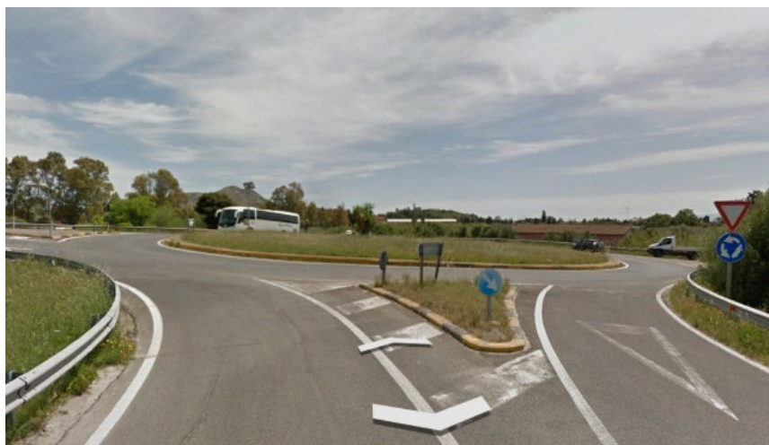
Figura 26 – Inquadramento della rotonda sulla SS128 dal lato sud-ovest.
