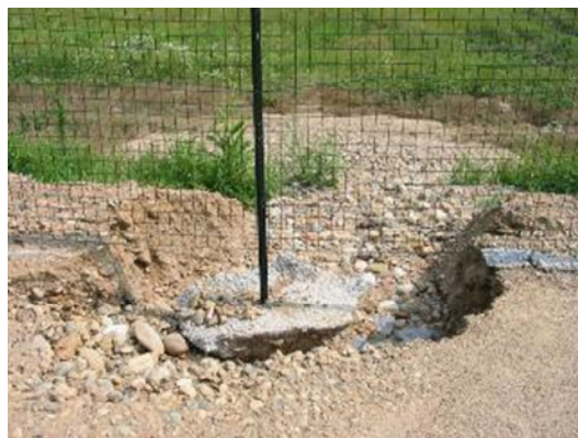
Figura 6 Fenomeni di erosione nei cantieri
