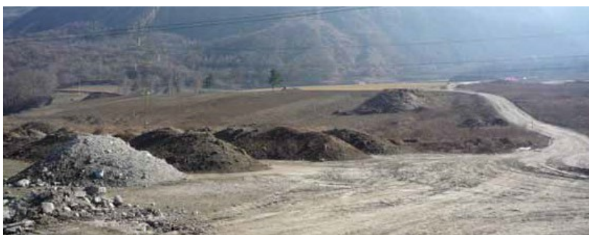
Figura 4 Separazione in cumuli degli orizzonti più superficiali e di quelli più profondi (Bassignana et al. 2011, modificato).
