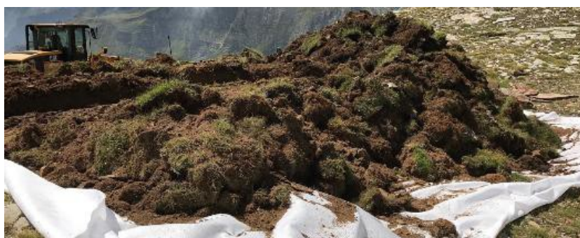
Figura 5 Stesura di un telo protettivo alla base del cumulo
