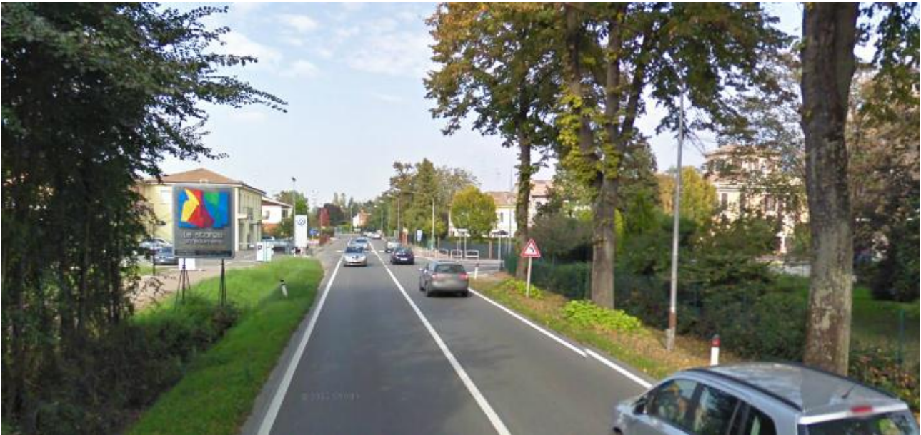
FIGURA 4.1 – STRADA STATALE 12 DELL'ABETONE ALLO STATO DI FATTO
