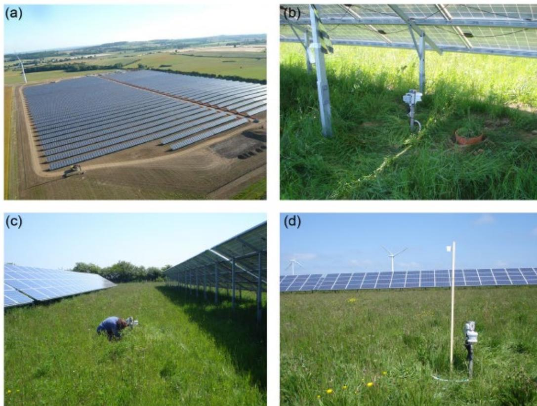
Figura 32- (a) foto aerea del Westmill Solar Park; (b) Under: punto di rilevamento sotto i moduli; (c) Gap: punto di rilevamento tra i filari di moduli; (d) Control: punto di rilevamento esterno
