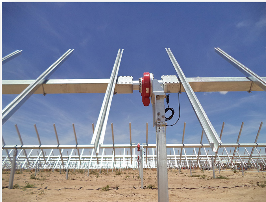
Figura 2 – Struttura dell'inseguitore solare monoassiale
