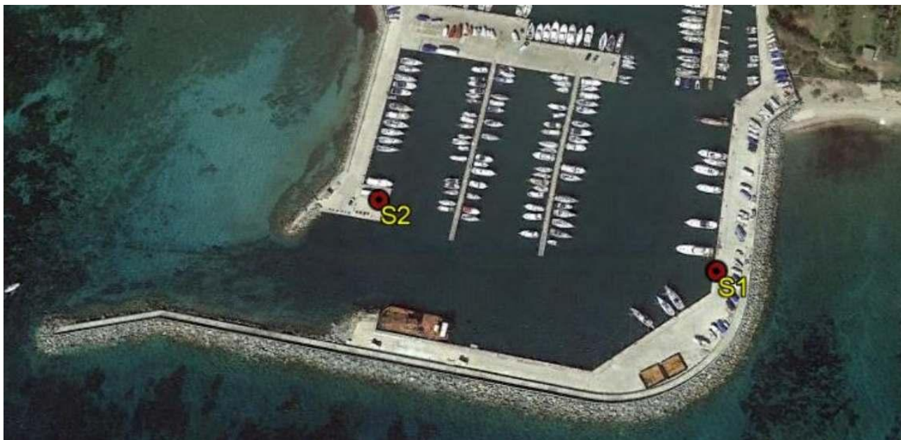
Fig.3 - Sondaggi effettuati in data 01/08/2019
