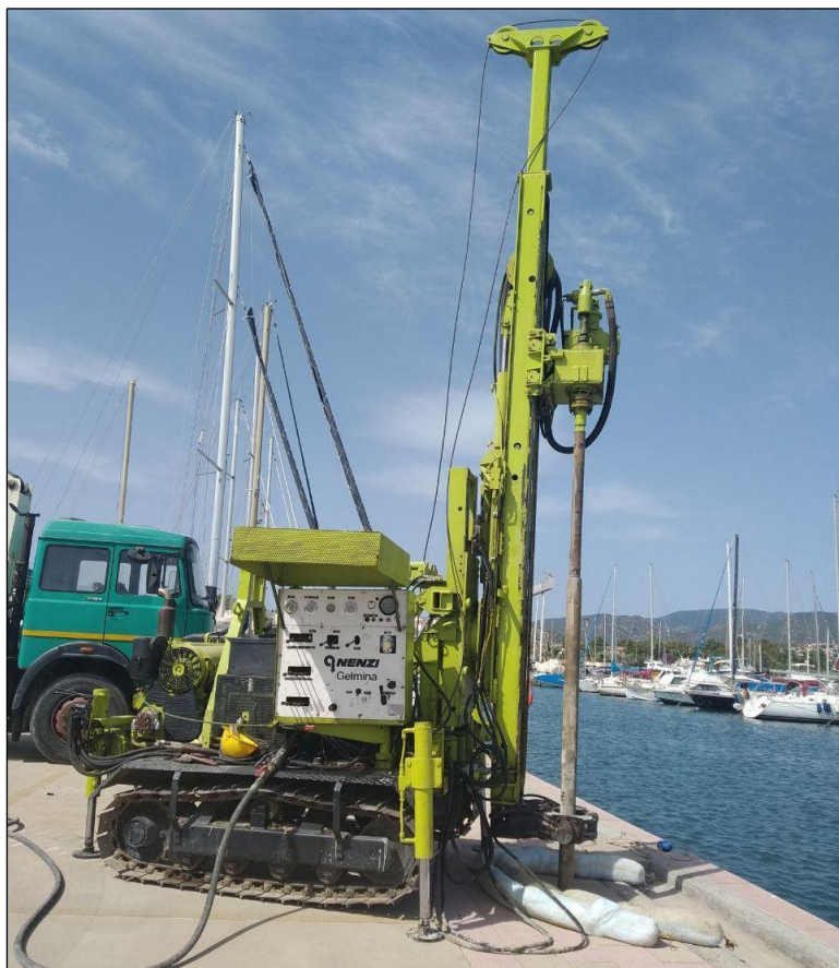
Figura 12. Esecuzione del sondaggio S2.
