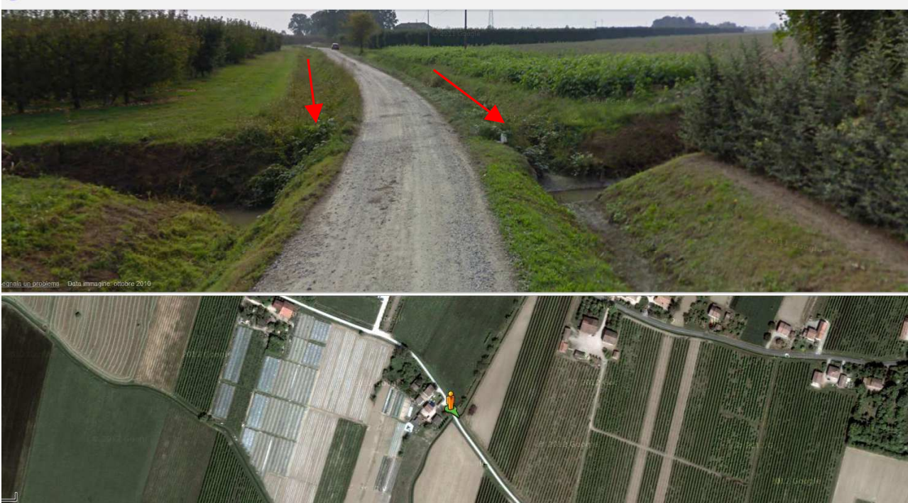
Figura 4.2 – Immagine della strada alla stato attuale con i Fossi 52 (in destra) e il canale di via Getta (in sinistra) esistenti che si immettono nella Fossa Reggiana
