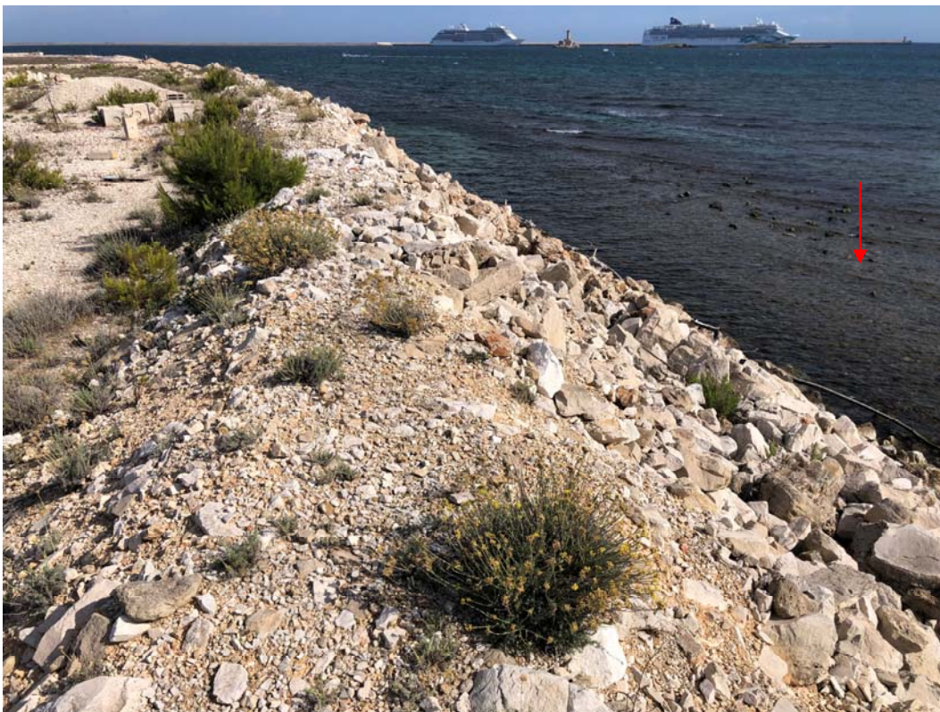
Fig.26 – L'argine di scarpata in materiale calcareo e calcareo-dolomitico, fianco est; visibile il locale substrato roccioso d'appoggio in calcarenite a "Panchina"; piano sedime in elevazione di ca.3.5 m slm
