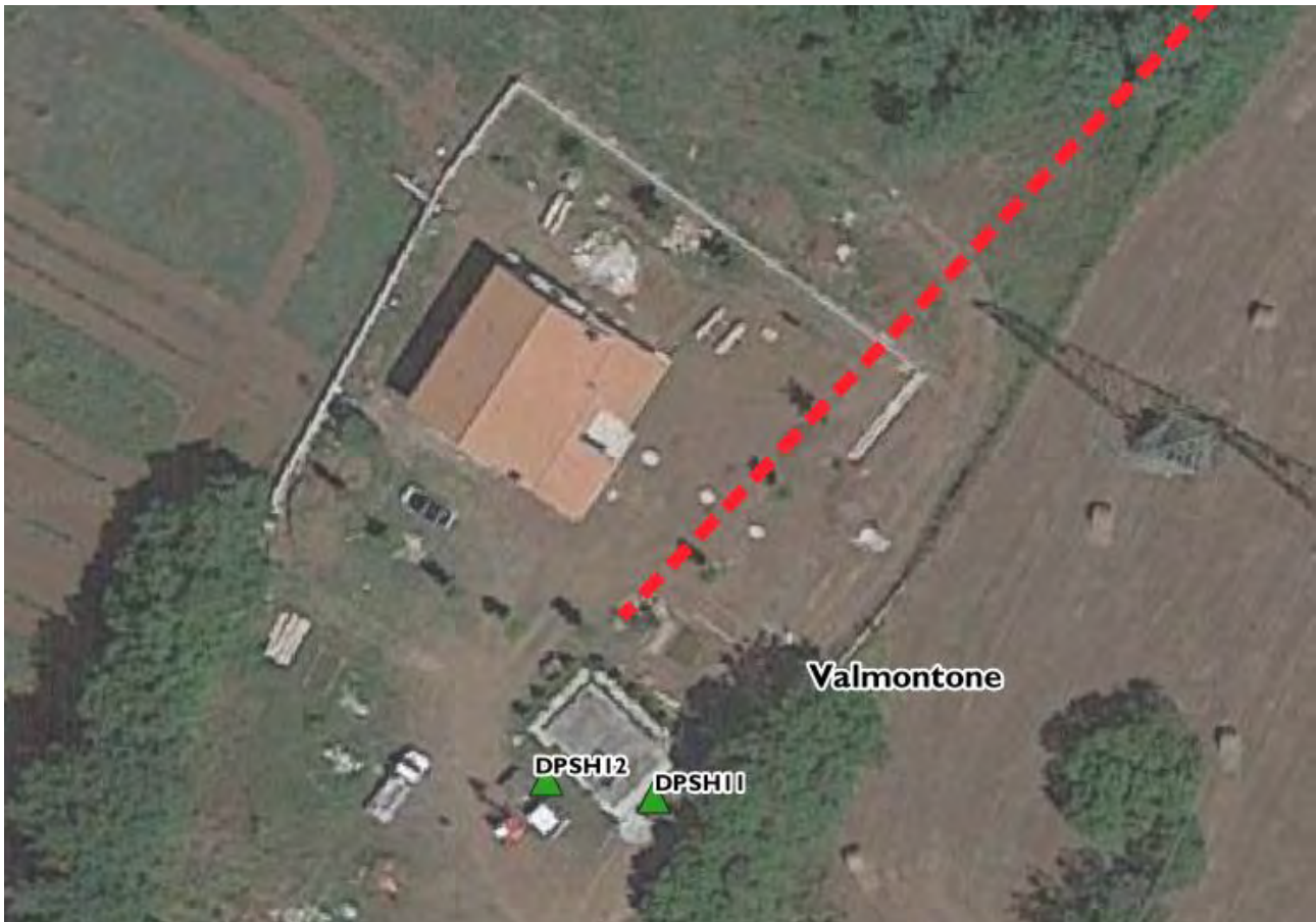
Figura 8.20. Ubicazione DPSH 11 e 12 nei pressi del Manufatto Partitore "Colle S. Angelo" (Tratto T2).
