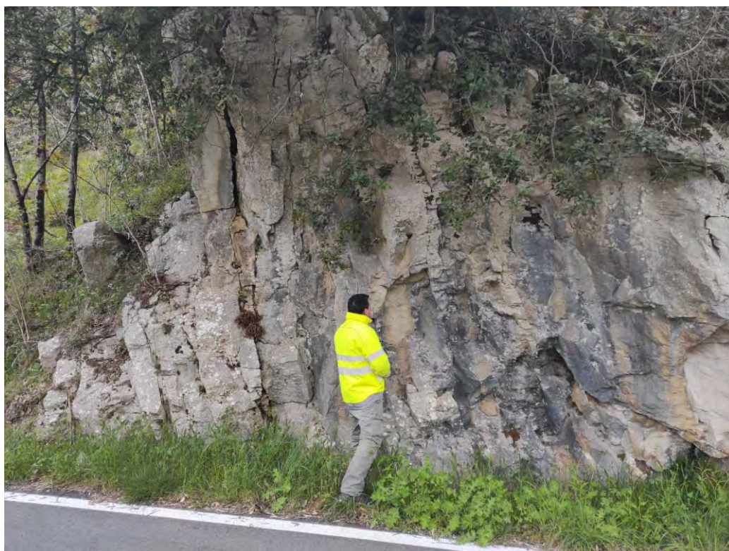
Figura 8.47. Fotografia della stazione geomeccanica K1.
