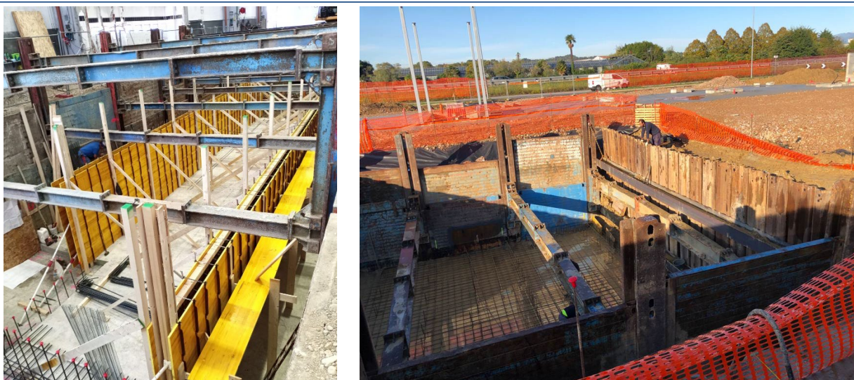
Figura 12-2 – blindaggi a cassa chiusa per la realizzazione di manufatti gettati in opera
