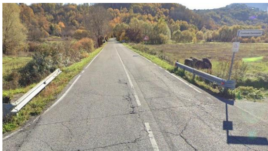
Figura 10. Strada Provinciale 50a.
