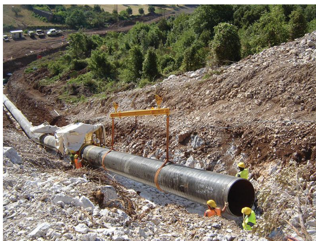
Figura 5. Messa in opera di condotte con teleferica
