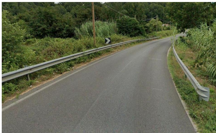
Figura 24. Strada provinciale Sp12a.
