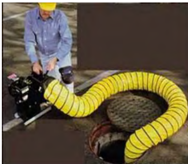
Figura – Esempio d'intervento di ventilazione.
